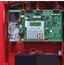
消防系统 多种传感器与自动控制系统一起监测楼宇温度，并确保灭火系统保持正常水压。
